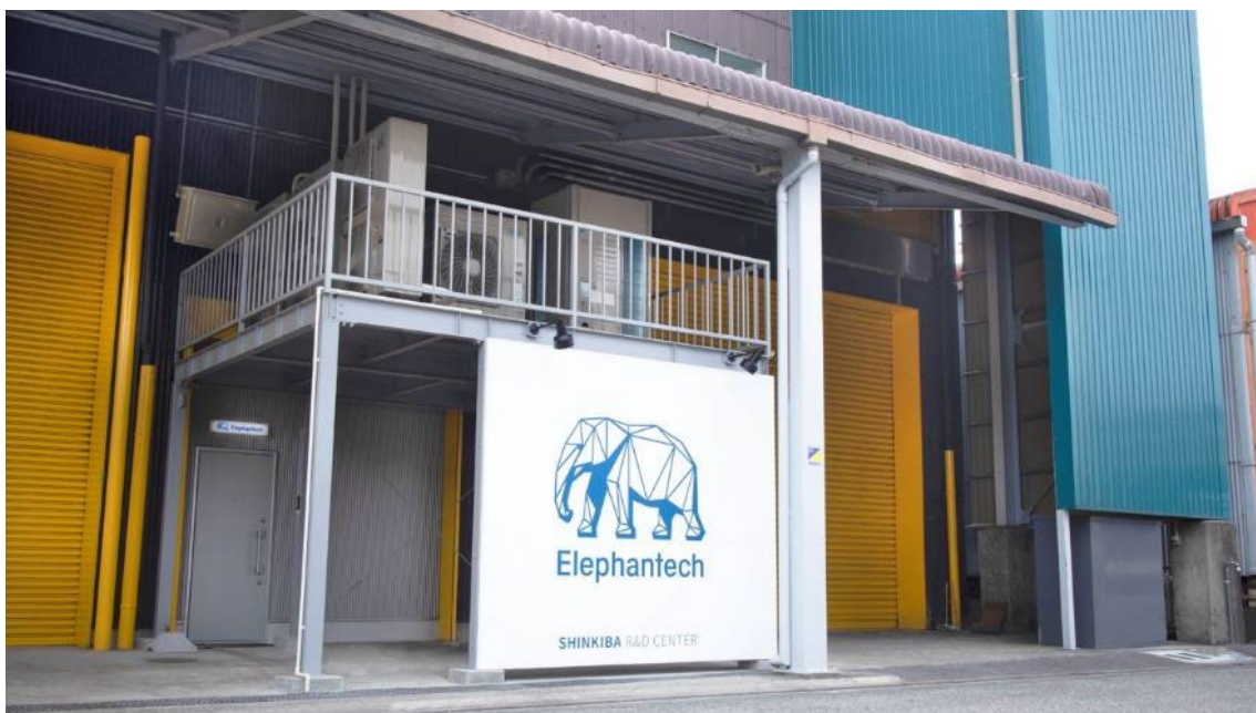
新木場 R&D センター外観
